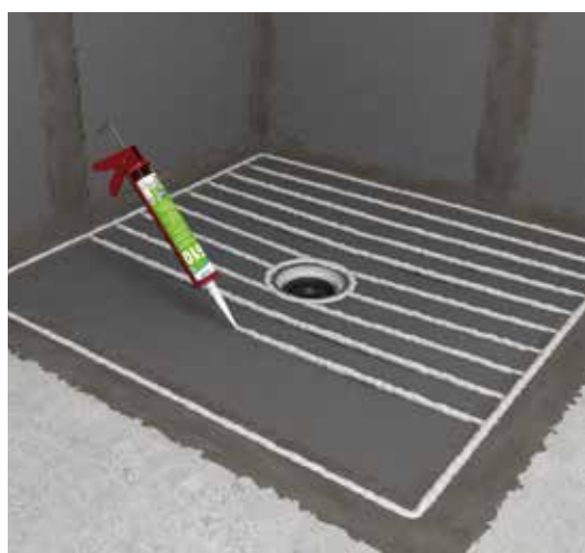
Kraftschlüssige Verklebung der Fundo Top Designoberflächen mit wedi 610 Kleb- und Dichtstoff.
